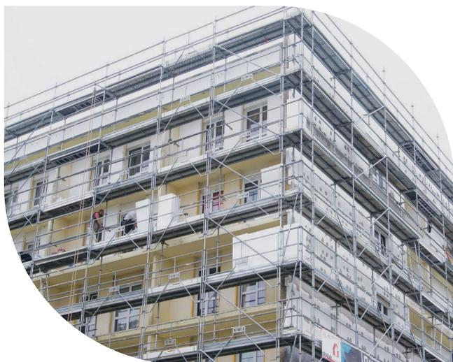
Le Système **EDIL-Therm®** est un procédé d'Isolation Thermique par l'Extérieur (I.T.E.) par enduit mince sur isolant en polystyrène expansé (PSE).
