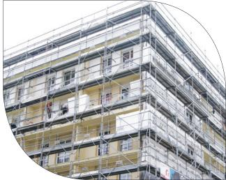
Le Système **EDIL-Therm®** est un procédé d'Isolation Thermique par l'Extérieur (I.T.E.) par enduit mince avec des plaques en polystyrène expansé (PSE) ou en Laine de Roche.
